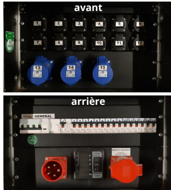
Armoire électrique (Flight) P17-32A
