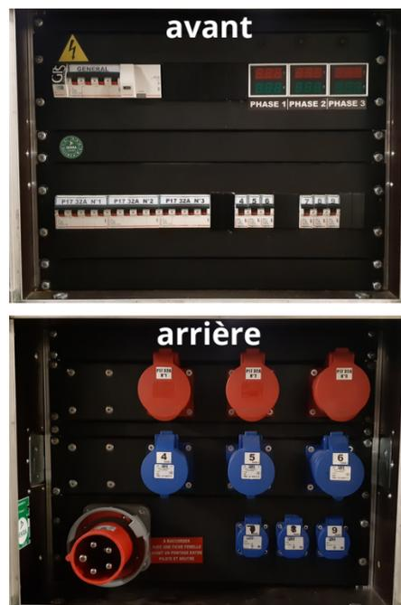
Armoire électrique (Flight) P17-63A
